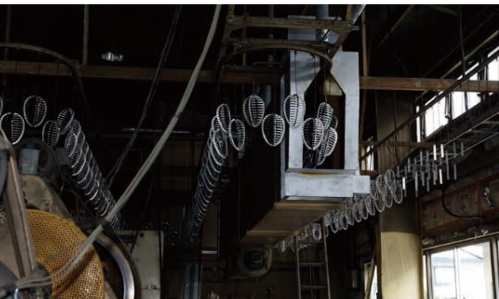
右上の金属の箱のようなものが、焼付 け塗装のための釜。この中を15分ほど かけて面金が移動する
